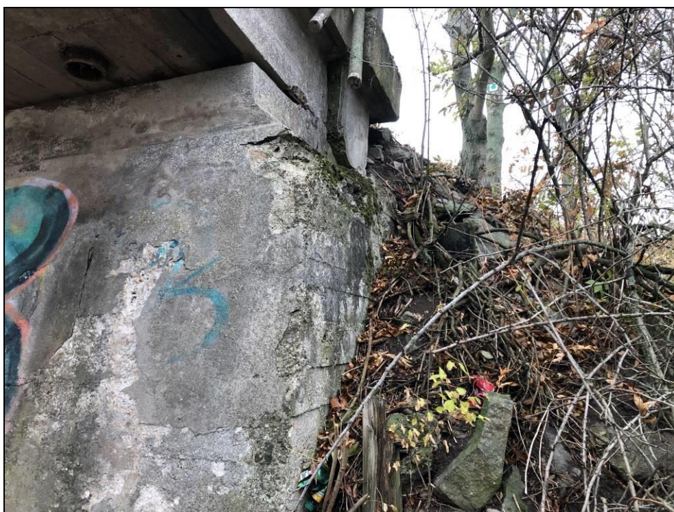
Obr. č. 6 – pohled na degradovaný beton opěry vpravo
