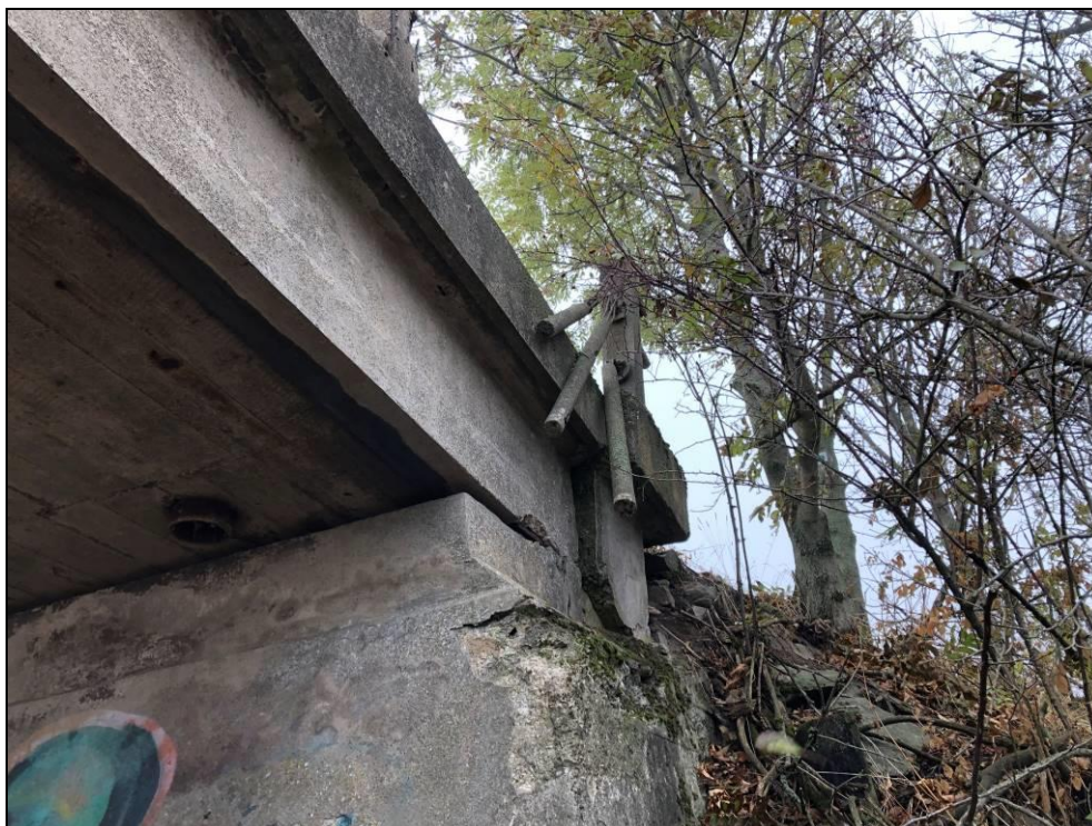
Obr. č. 5 – pohled na odtržené zábradlí
