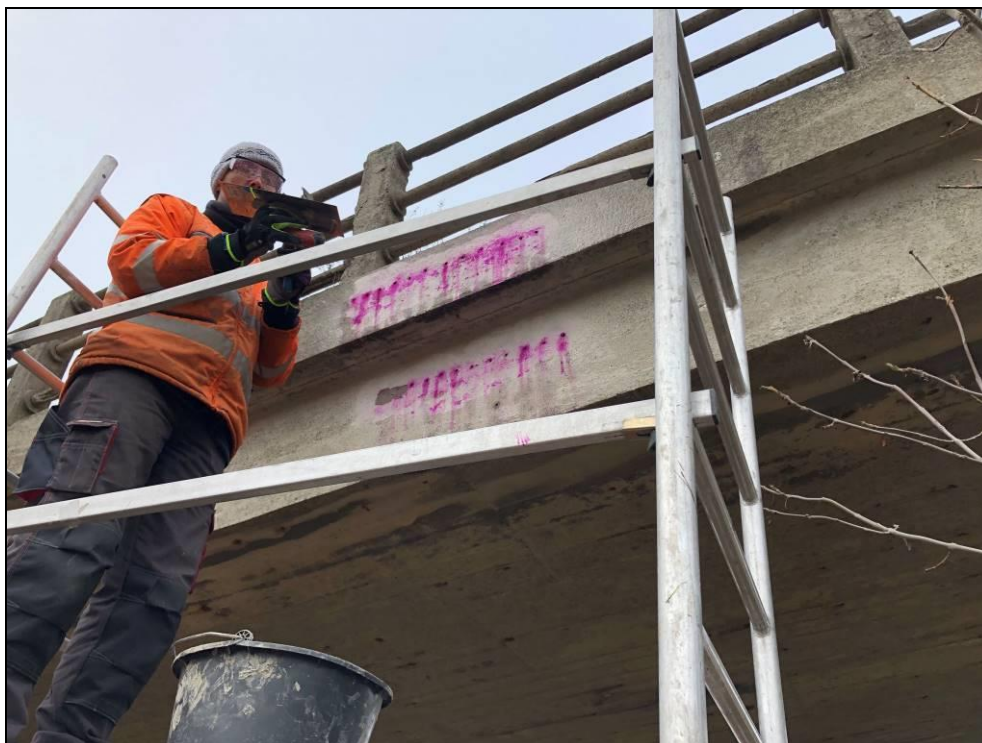
Obr. č. 7 – pohled na místo nosnou konstrukci a římsu, kde se provádělo měření mocnosti karbonatace a hloubky krytí ocelové výztuže
